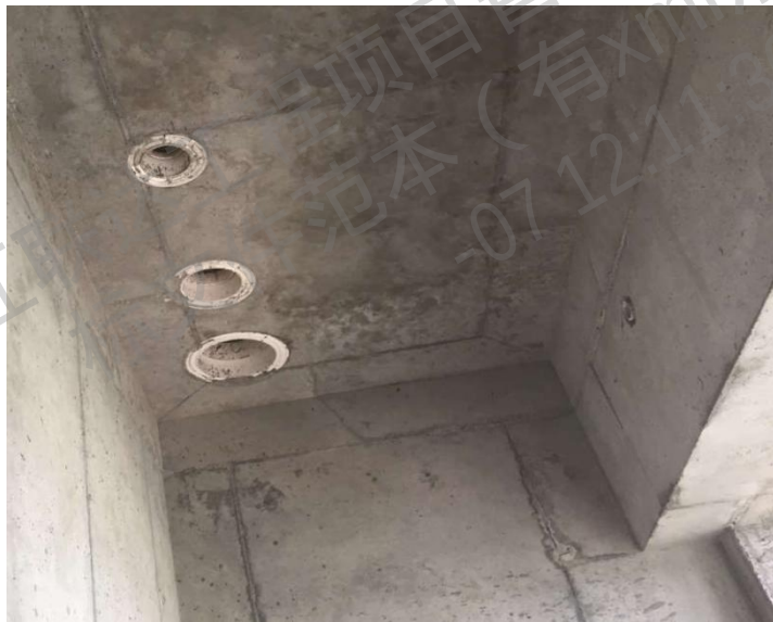
排水预埋式直接安装后效果
