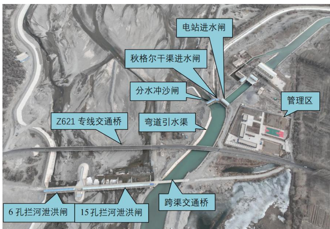
图 1-3 拦河泄洪闸、拦河泄洪冲沙闸上游现状
