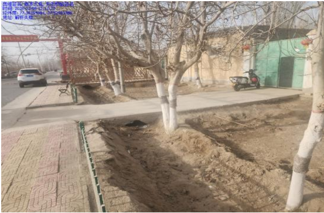
图 5.1-6 4 村 2、3 组斗渠 6 现状
