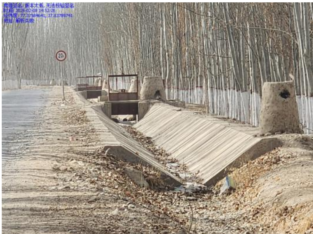
图 5.1-5 4 村 2 组斗渠 5 现状
