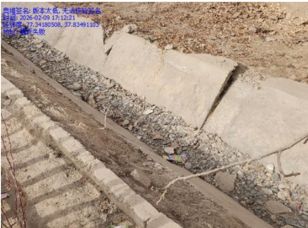
图 5.1-10 7 村 3 组斗渠 10 现状
