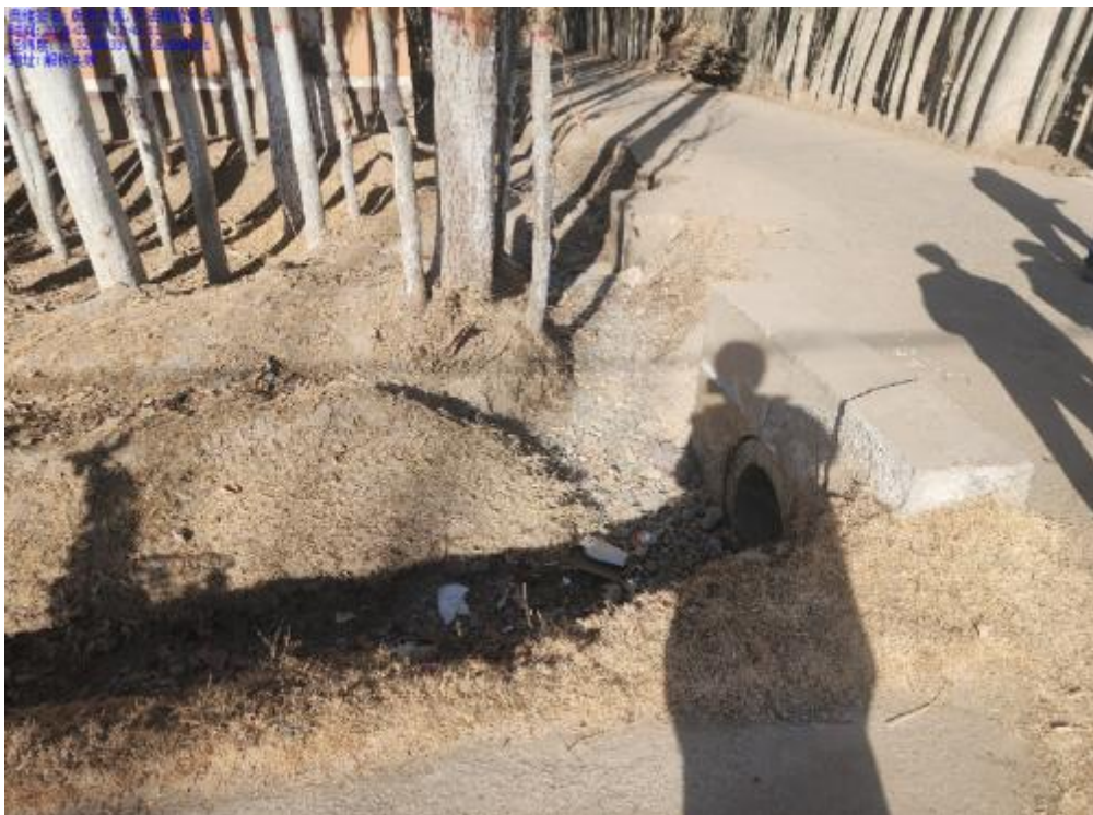
图 5.1-1 2 村 3 组斗渠 1 现状
