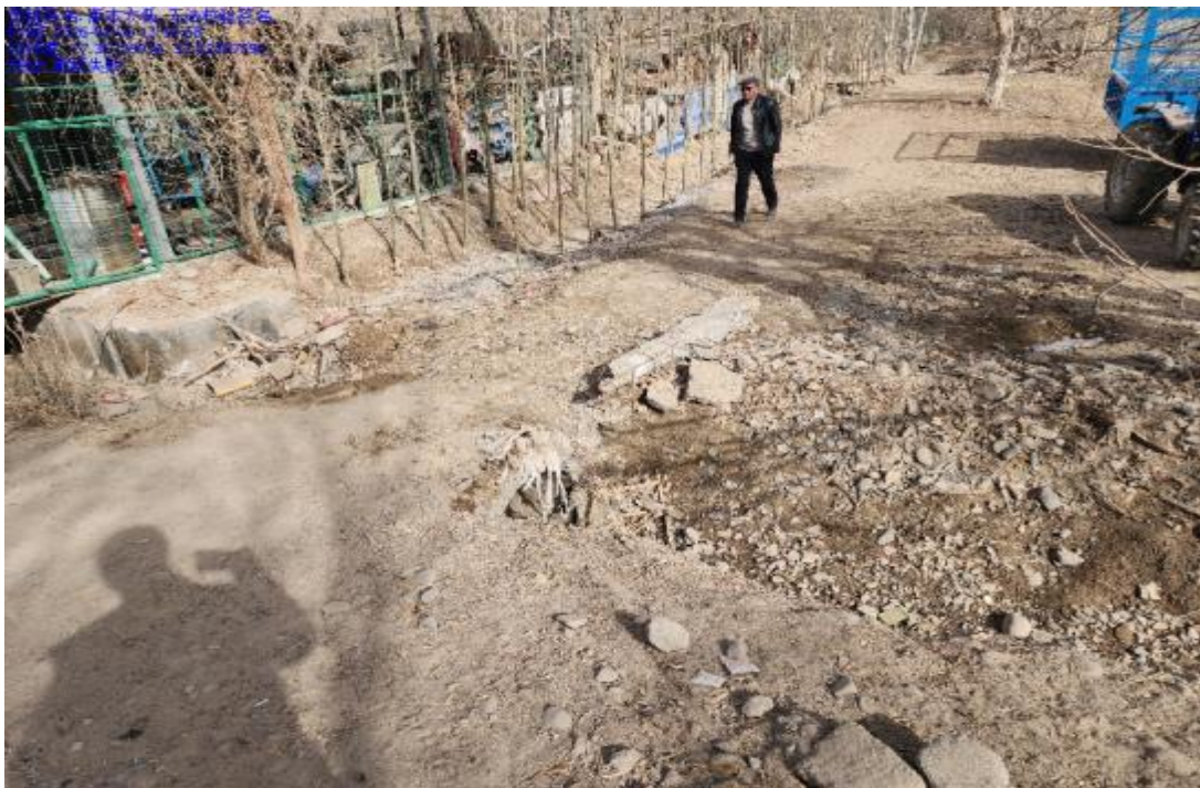
图 5.1-7 4 村 3 组斗渠 7 现状
