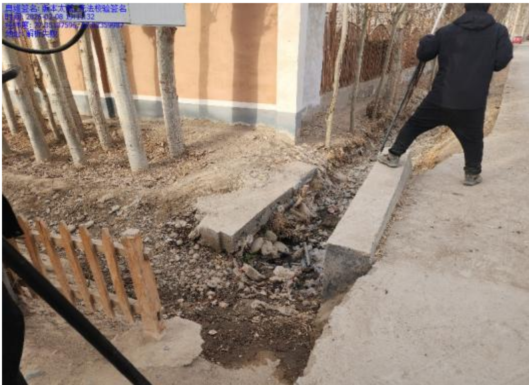
图 5.1-8 6 村 1 组斗渠 8 现状 现状不足：现状为土渠，分水口简陋，涵桥缺失，全线淤积。
