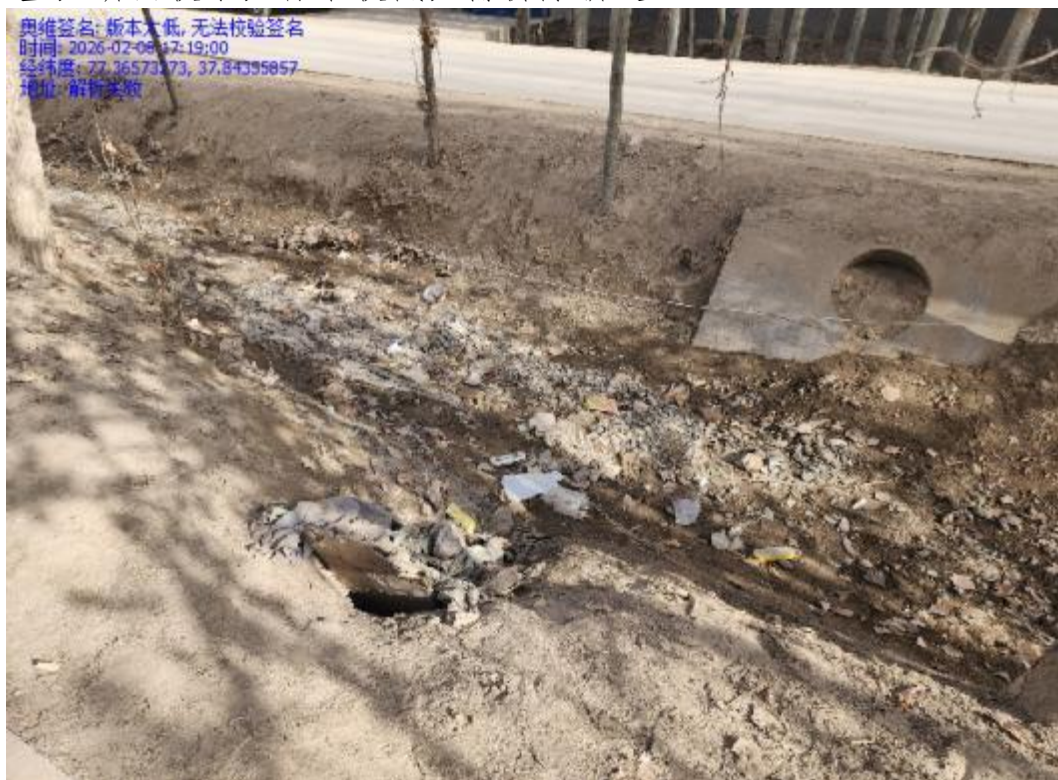
图 5.1-11 9 村 5 组斗渠 11 现状
