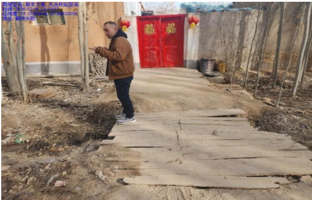
图 5.1-12 10 村 1 组斗渠 12 现状 现状不足： 现状为土渠，分水口简陋，入户桥简陋，淤积严重。
