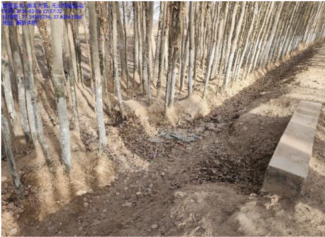
图 5.1-8 6 村 1 组斗渠 8 现状 现状不足：现状为土渠，分水口简陋，涵桥缺失，全线淤积。
