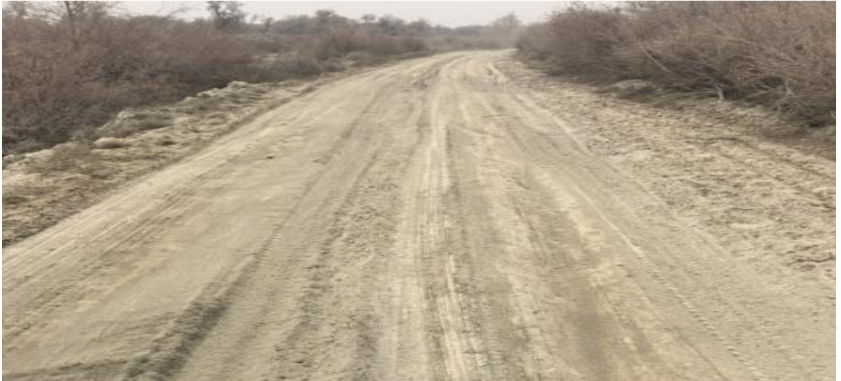
图 4.2-28 海楼牧场引水闸~二牧场二大队输水堤现状-02
