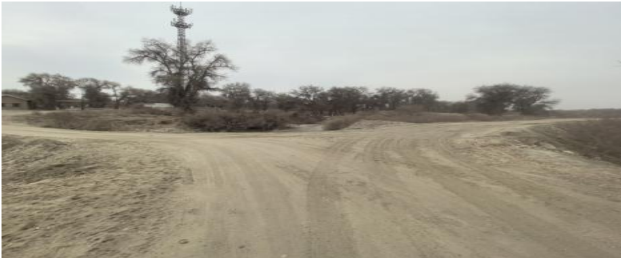
图 4.2-27 海楼牧场引水闸~二牧场二大队段输水堤现状-01
