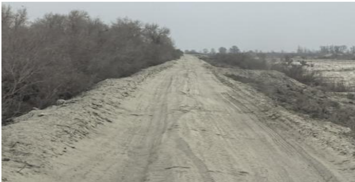
图 4.2-15 大寨水库引水闸~沙德克确了段输水堤现状-01
