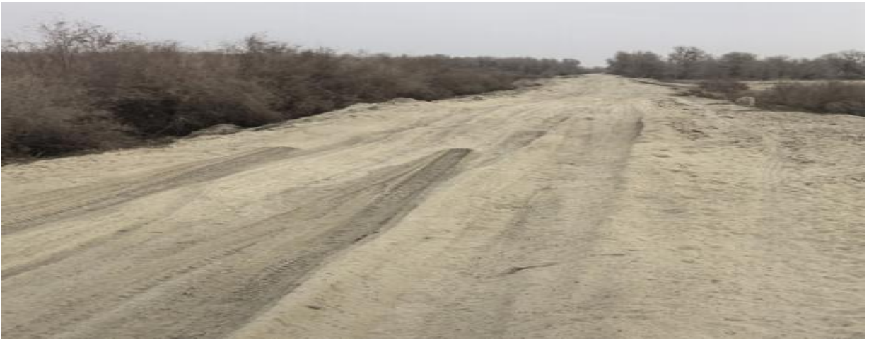
图 4.2-20 金托引水闸~恰克马克段输水堤现状-02
