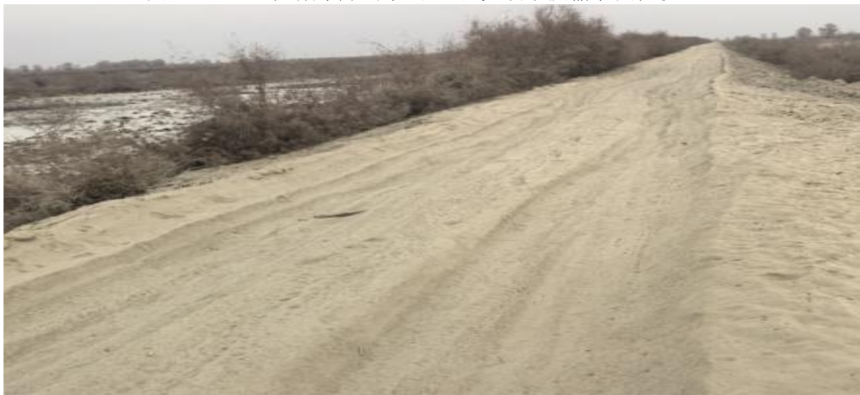
图 4.2-16 大寨水库引水闸~沙德克确了段输水堤现状-02
