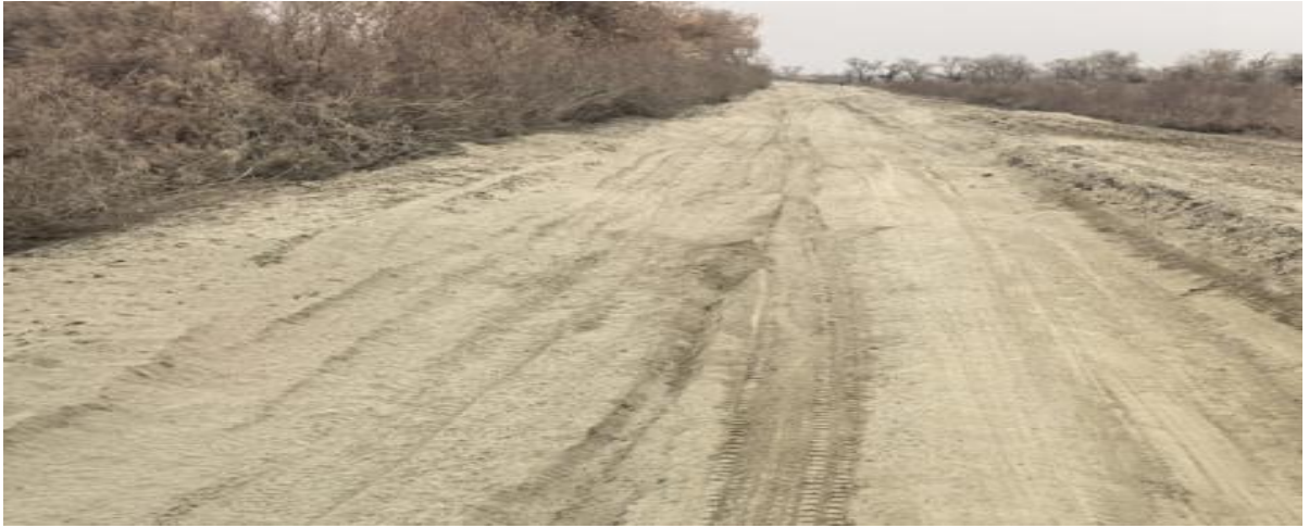
图 4.2-24 恰克马克引水闸~海楼牧场段输水堤现状-02
