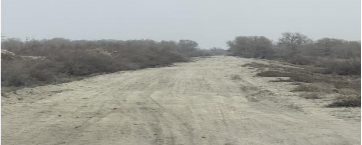
图 4.2-19 金托引水闸~恰克马克段输水堤现状-01
