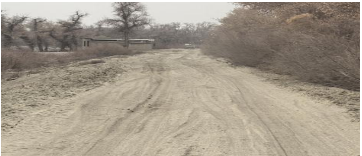
图 4.2-23 恰克马克引水闸~海楼牧场段输水堤现状-01
